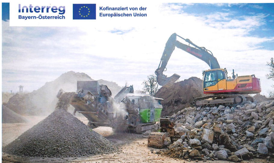
Grenzüberschreitendes Projekt „RIBA - Recycling in Use“ für mehr Kreislaufwirtschaft am Bau
